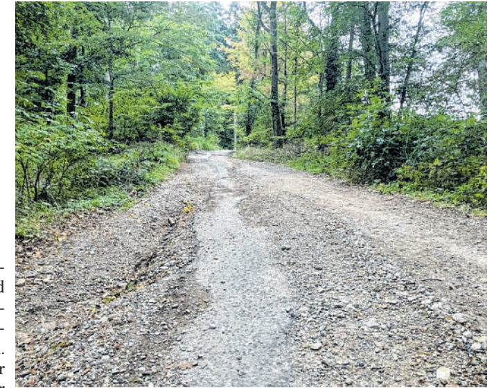
Umleitung ausgeschildert: Der Bauhof wird den Bärsbacher Weg in den nächsten vier Wochen sanieren. BILD: STADT WEINHEIM
